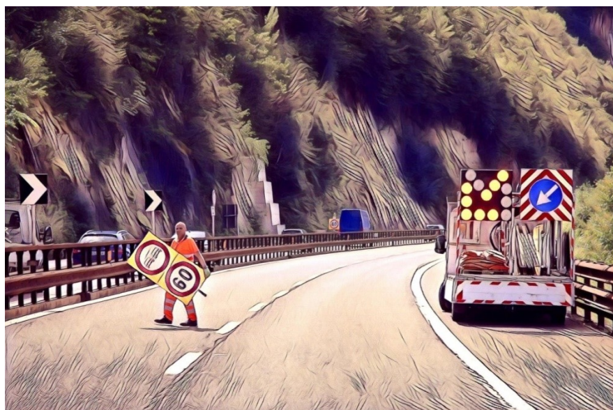
Chiusura della corsia di marcia: installazione della segnaletica di preavviso
