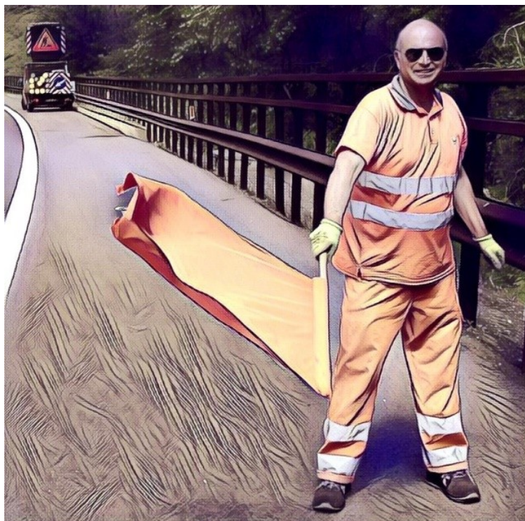
Chiusura della corsia di sorpasso: presegnalazione ed installazione del segnale di lavori in corso sul margine destro
