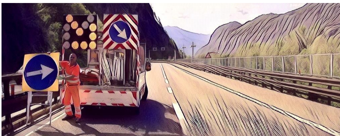
Chiusura della corsia di sorpasso: inizio installazione della testata di esclusione della corsia
