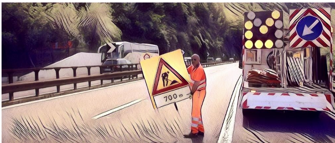
Chiusura della corsia di marcia: installazione del segnale di lavori in corso sul margine sinistro
