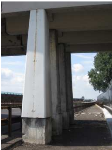
Incamiciatura pilastro della pila est
