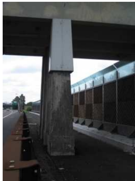
Incamiciatura testa pilastro della pila ovest
