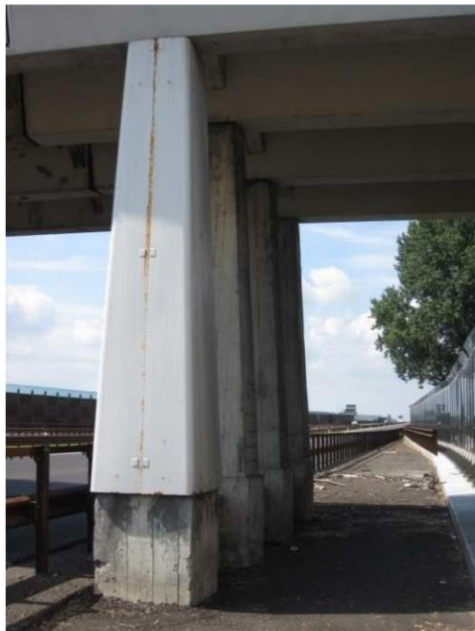
Incamiciatura pilastro della pila est
