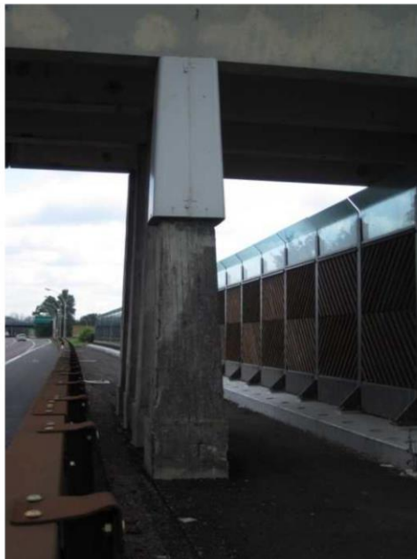
Incamiciatura testa pilastro della pila ovest
