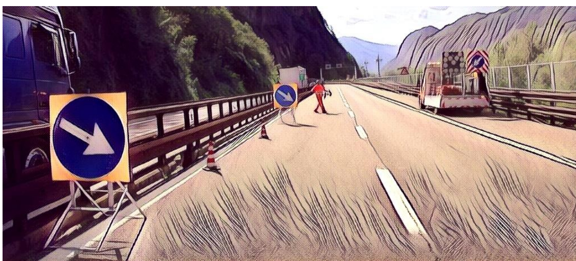
Chiusura della corsia di sorpasso: inizio installazione della testata di esclusione della corsia
