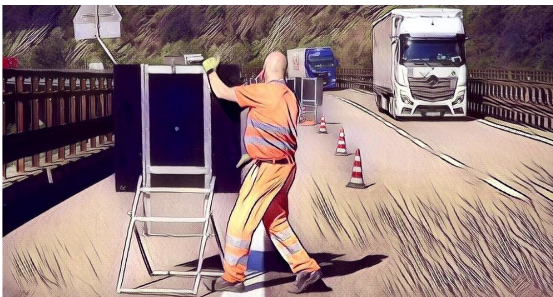
Chiusura della corsia di marcia: installazione della testata
