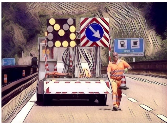
Posizionamento dei coni o dei delineatori flessibili: comportamento corretto
