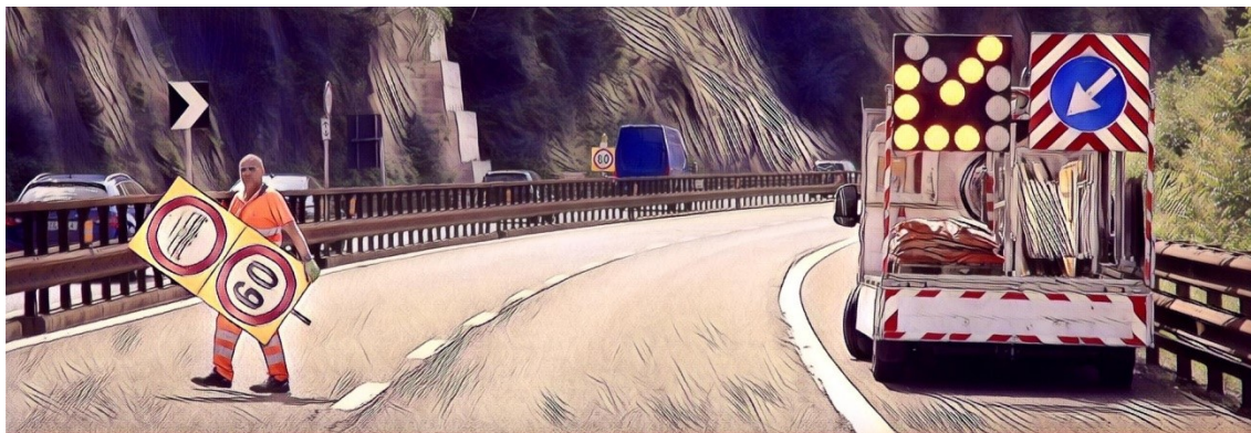
Chiusura della corsia di sorpasso: installazione del segnale sul margine sinistro
