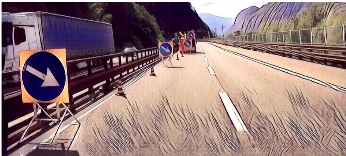
Chiusura della corsia di sorpasso: installazione della testata di esclusione della corsia
