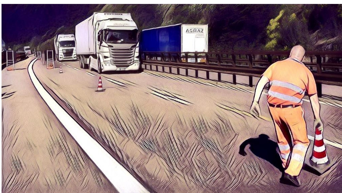
Chiusura della corsia di marcia: inizio della posa dei coni
