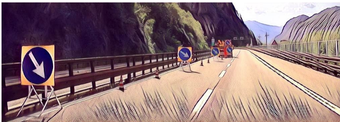
Chiusura della corsia di sorpasso: installazione della testata di esclusione della corsia
