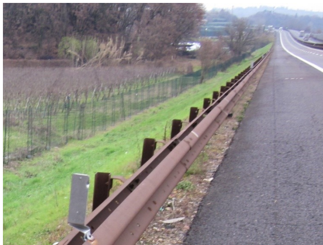
Figura 3-1 Tratto di autostrada protetto da sicurvia tipo H2
