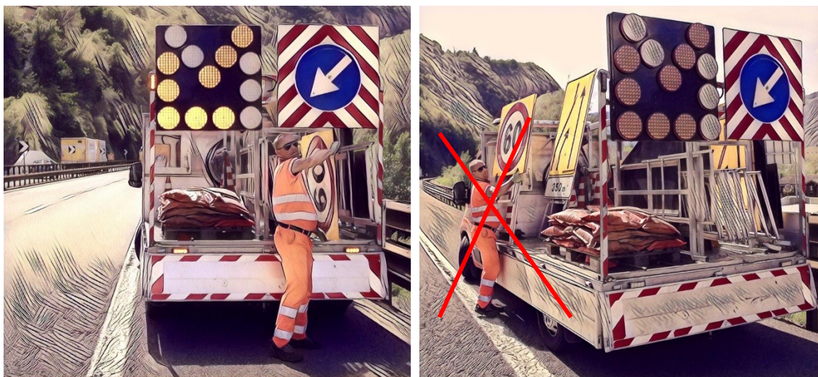
Prelevamento della segnaletica da automezzo: comportamento corretto (sinistra) e scorretto (destra)
