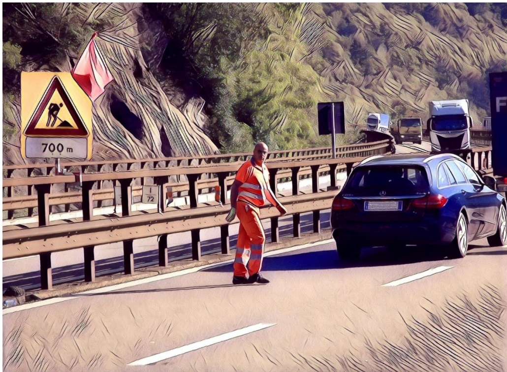
Chiusura della corsia di sorpasso: installazione del segnale sul margine sinistro
