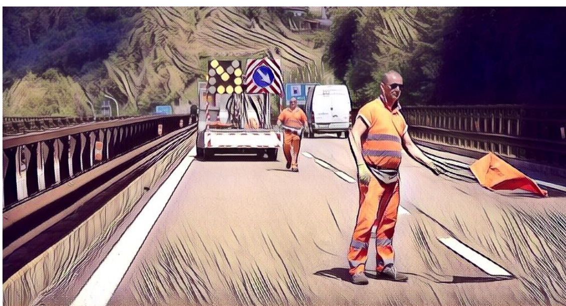
Chiusura della corsia di sorpasso: posa dei coni
