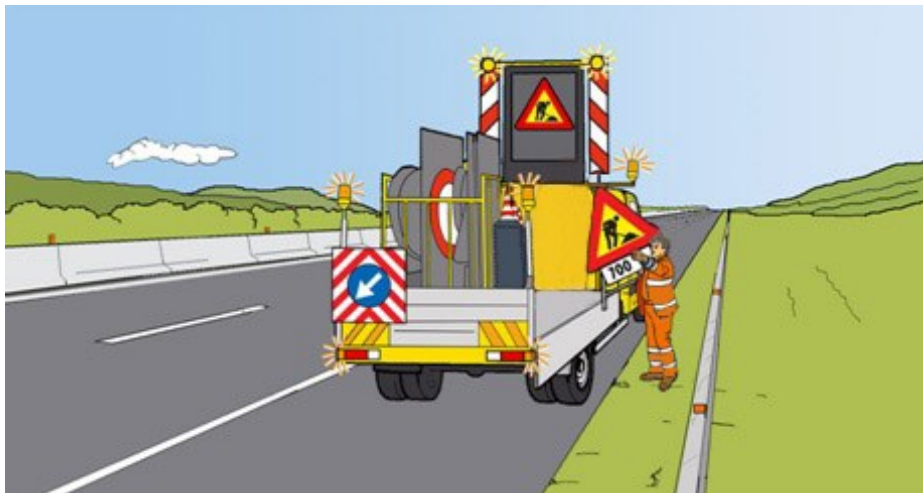
Figura 27 – Chiusura della corsia di sorpasso: scarico ed installazione del segnale di lavori in corso sul margine destro
